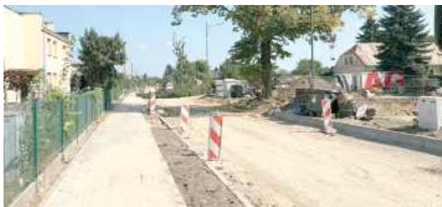
Prace na ul. Folwarki w Gołębiu nie zostały jeszcze zakończone
