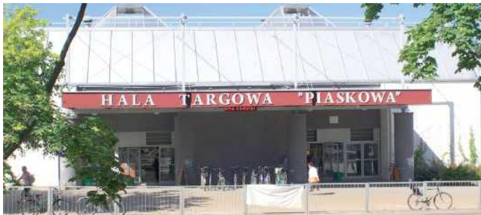
Obiekt przy ul. Piaskowej został oddany do użytku na początku 2009 r. Miał zastąpić mieszczący się tu targ oraz targowisko przy ul. Centralnej, tzw. „Manhattan”. W tej chwili w hali jest wolnych 61 boksów
