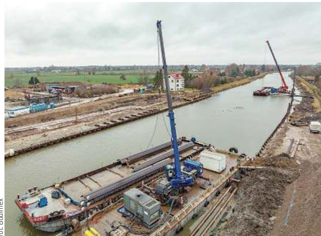
Jednocześnie trwają prace przy realizacji drugiego etapu
