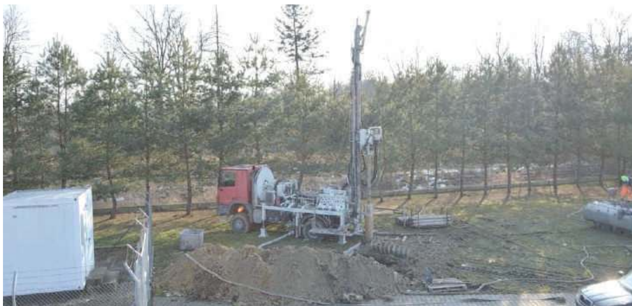
Prace już ruszyły
