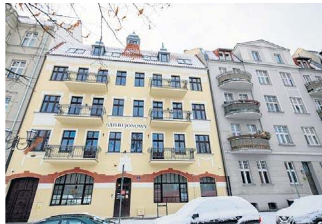
Nowością jest napis „Sąd Rejonowy”, który pojawił się w centralnym punkcie frontowej ściany
