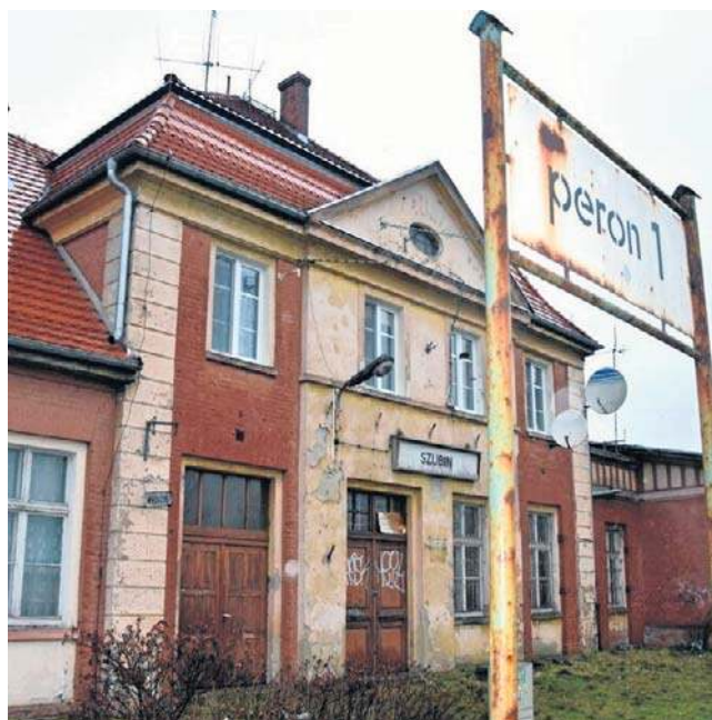
Dworzec kolejowy w Szubinie opustoszał wiele lat temu. Są zapowiedzi wznowienia połączeń do Kcyni i Bydgoszczy i utworzenia w oparciu o tę trasę kolei metropolitalnej łączącej Wielkopolskę z bydgoskim Fordonem. Uda się? Trzymamy kciuki!
