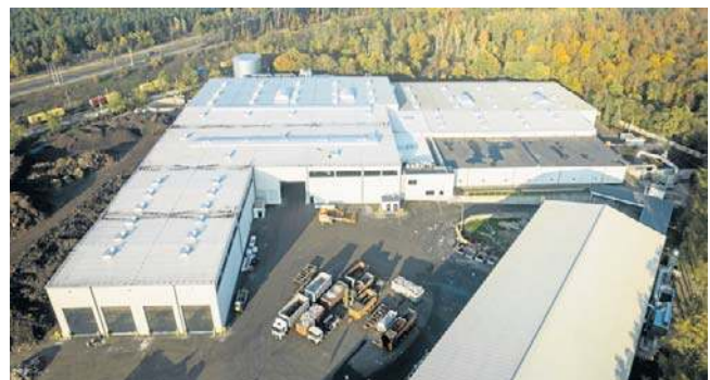
Prace przy nowej hali Remondisu przy ulicy Inwalidów zakończono jesienią 2024 roku
