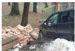
Ogrodzenie zostało mocno uszkodzone
