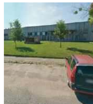
W miejscu dawnego supermarketu przy ul. Boenigka 7 powstanie blok mieszkalny
