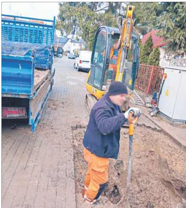
Ekipa pogotowia wodociągowego wykazała się niesamowitą sprawnością.
