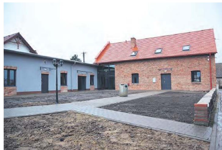
W budżecie jest sporo zadań, które miały być zakończone i rozliczone w minionym roku, w tym m.in. przebudowa budynku przy ul. Wczasowej.
