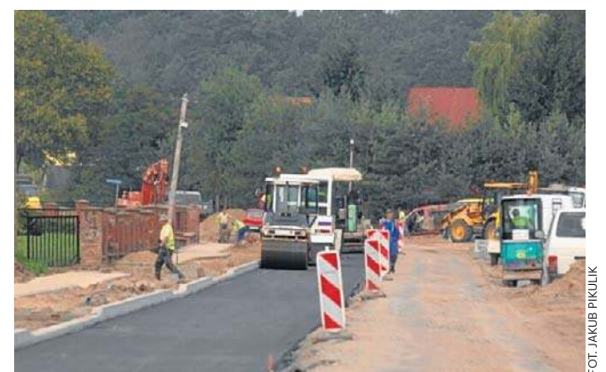
Tak wyglądała ulica Dobra piętnaście lat temu, gdy trwała jej gruntowna przebudowa
