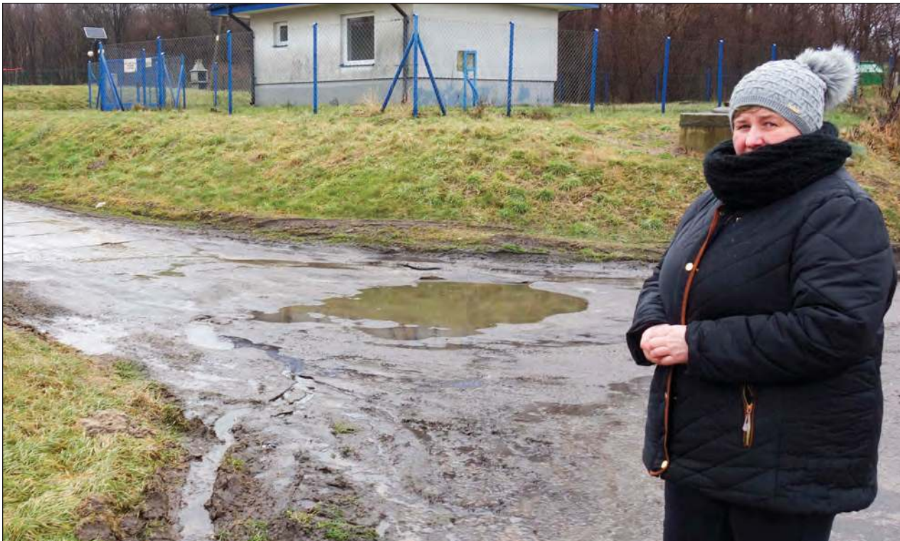
❖ Droga z betonowych płyt, biegnąca do bloków, wymaga remontu. - Najgorzej jest na początku, bo wjechanie w olbrzymi dół może spowodować uszkodzenie samochodu - wyjaśnia radna Edyta Kopacz
