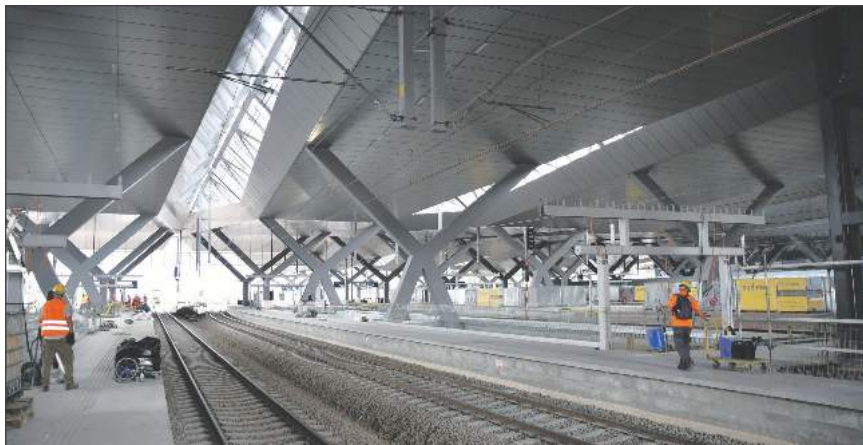
Przebudowa Warszawy Zachodniej była tańsza, choć dworzec był większy. Kolejarze mają się uczyć na błędach tamtego remontu (fot. PKP PLK)
