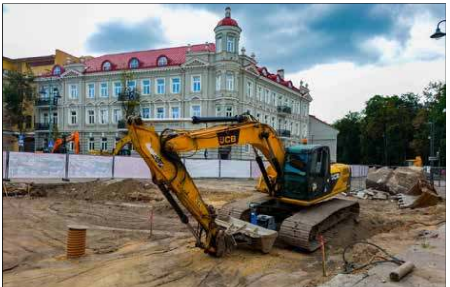
Prace w historycznej części miasta, są uzależnione od wymogów związanych z ochroną zabytków i dziedzictwa archeologicznego Fot. Marian Paluszkiewicz
