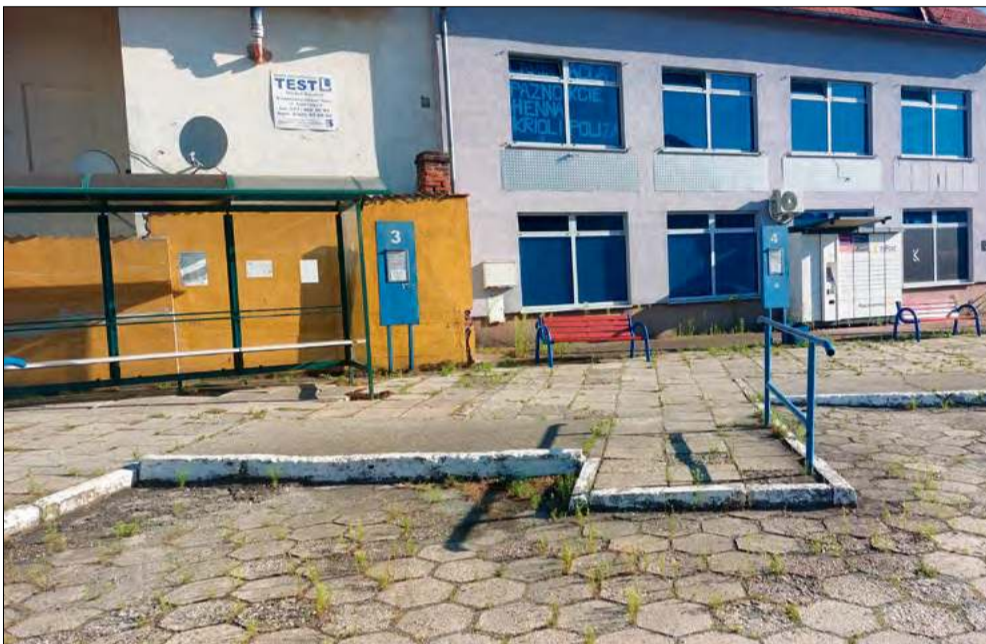
Stary PKS w Krapkowicach zmieni się nie do poznania. Na rozpoczęcie prac budowlanych trzeba jeszcze trochę poczekać.
