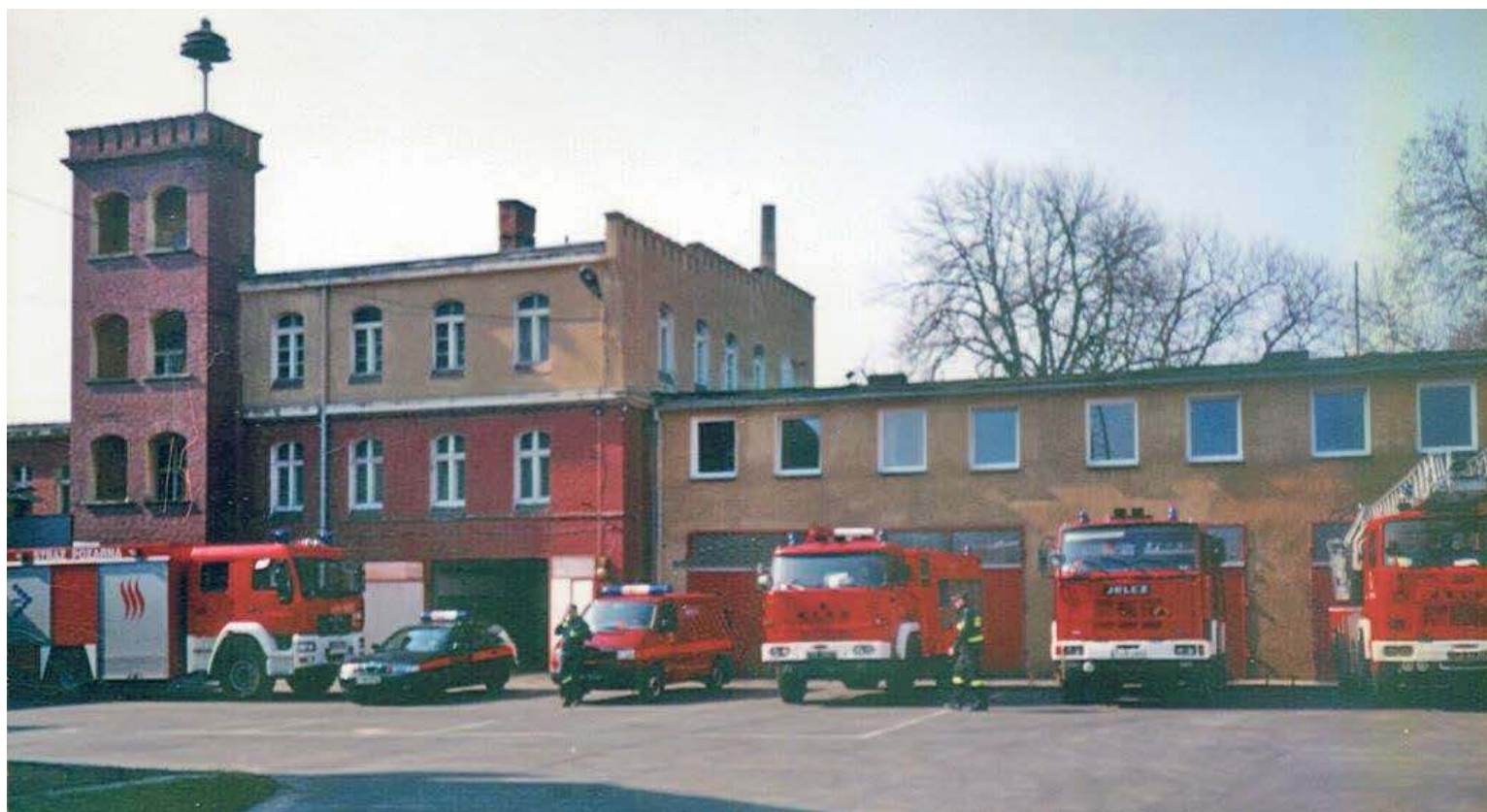
Wyposażenie Jednostki Ratowniczo-Gaśniczej na tle garaży dobudowanych w latach 60.
