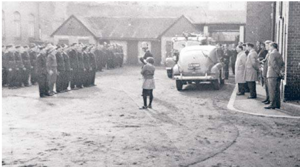
Widok na komórki, na miejscu których wybudowano boksy garażowe w latach 80.
