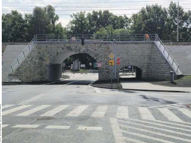
Wiadukt na ul. Siennej
