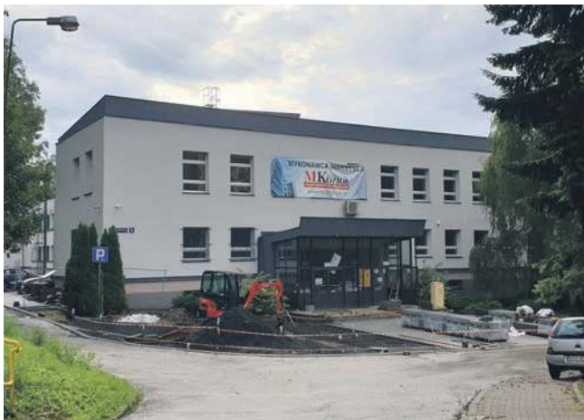
Wejście do przyszłej szkoły muzycznej w Chrzanowie
