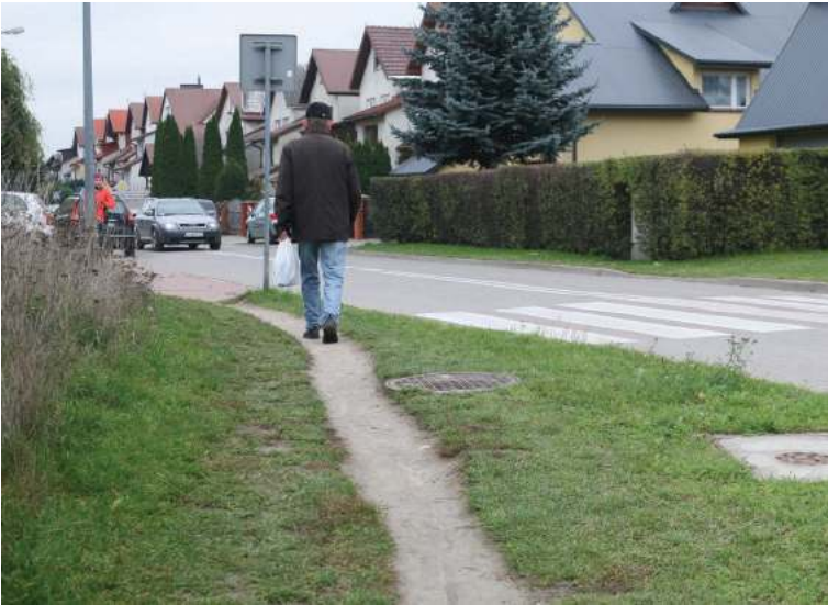
Jeszcze w tym roku do pasów, obecnie prowadzących od trawnika do trawnika, będzie można dotrzeć po chodniku
