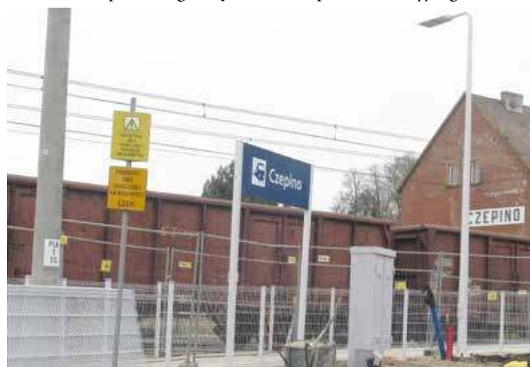
Dworzec PKP w Czepinie przebudowywany w ramach projektu metropolitalnego.
