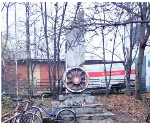
Pomnik jest złym stanem technicznym, dlatego konieczne jest przeprowadzenie jego prac remontowych. Obecnie służy za podpórkę dla rowerów
