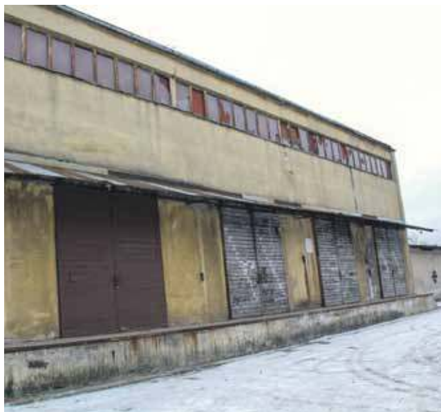
Magazyny przy Konfederacji Tatrzańskiej są w fatalnym stanie. Komu opłaci się remont?
