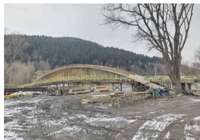
Budowa kładki na Dunajcu w Krościenku nabiera tempa.
