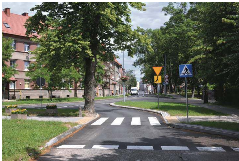
Przebudowana ulica Kolejowa w Olecku
