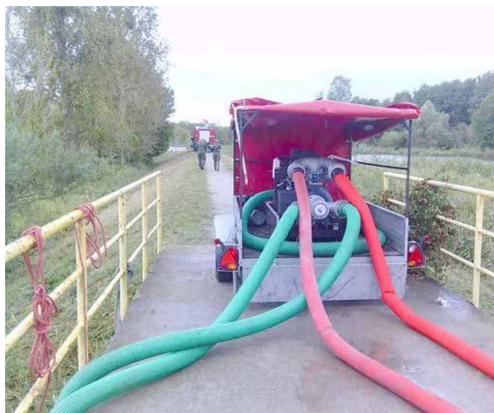
Na Czechosłowackiej trzeba było pompować wodę
