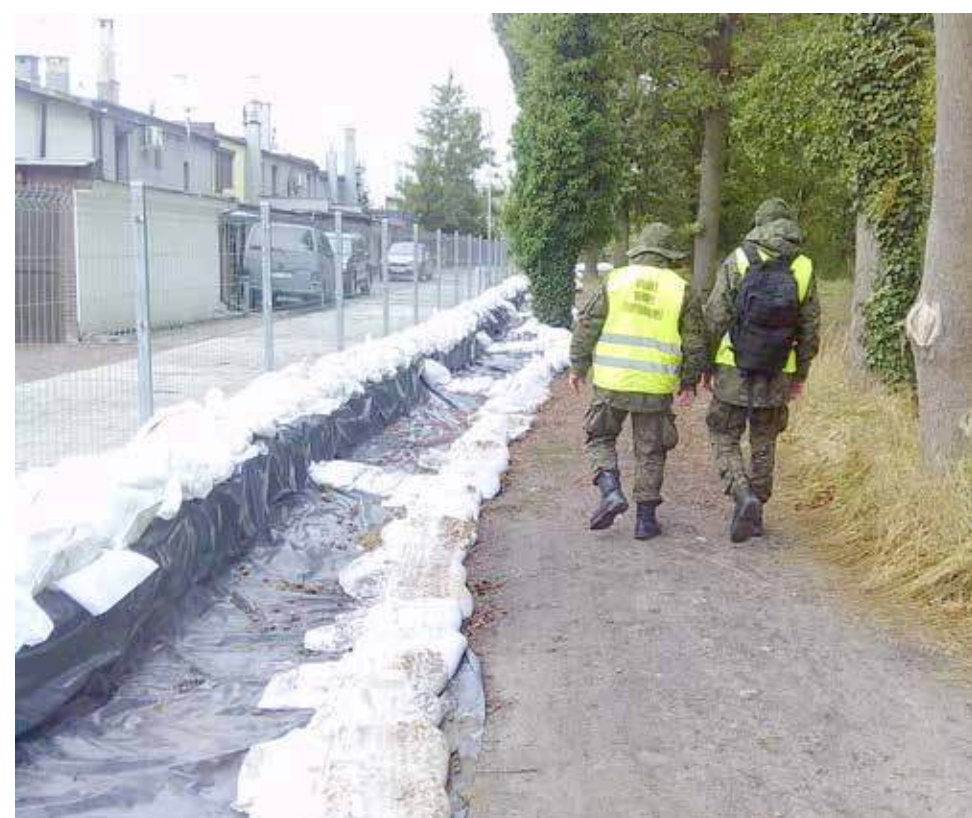
Zdarza się, że kierowcy niszczą zabezpieczenia z worków z piaskiem
