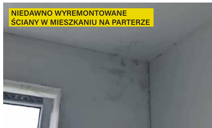
TAK WYGLĄDA ŚCIANA NA PARTERZE, PODDAWANA PRZEZ LATA DZIAŁANIU WODY ŚCIEKAJĄCEJ Z DACHU
