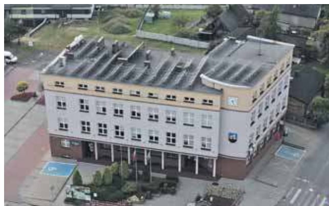
W Urzędzie Miejskim w Kaletach planowany jest montaż dwóch kotłów na biomasę oraz magazynu energii elektrycznej
