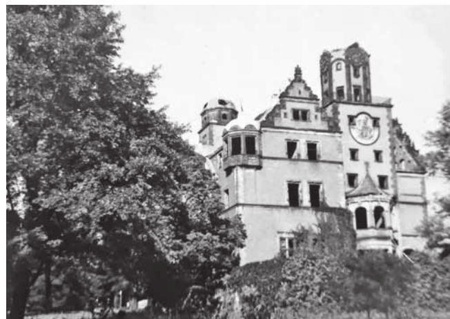
W związku z budową Górniczego Centrum Rehabilitacyjnego, ruiny pałacu zostały wyburzone
