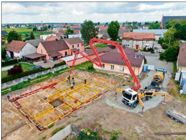
Wylano już pierwsze fundamenty pod budowę centrum.
