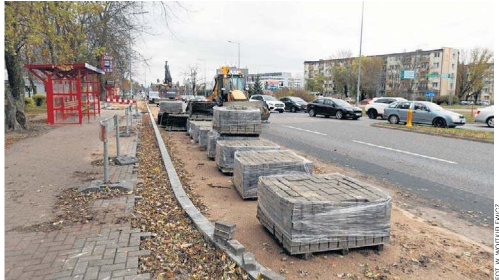
Przebudowa zatoki autobusowej przy przystanku na skrzyżowaniu Zwycięstwa i Hetmańskiej ruszyła 13 października, planowany termin zakończenia prac to 8 listopada
