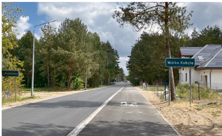
Gmina realizowała inwestycję drogową, która przebiega tuż obok posesji państwa Wierzbickich.
