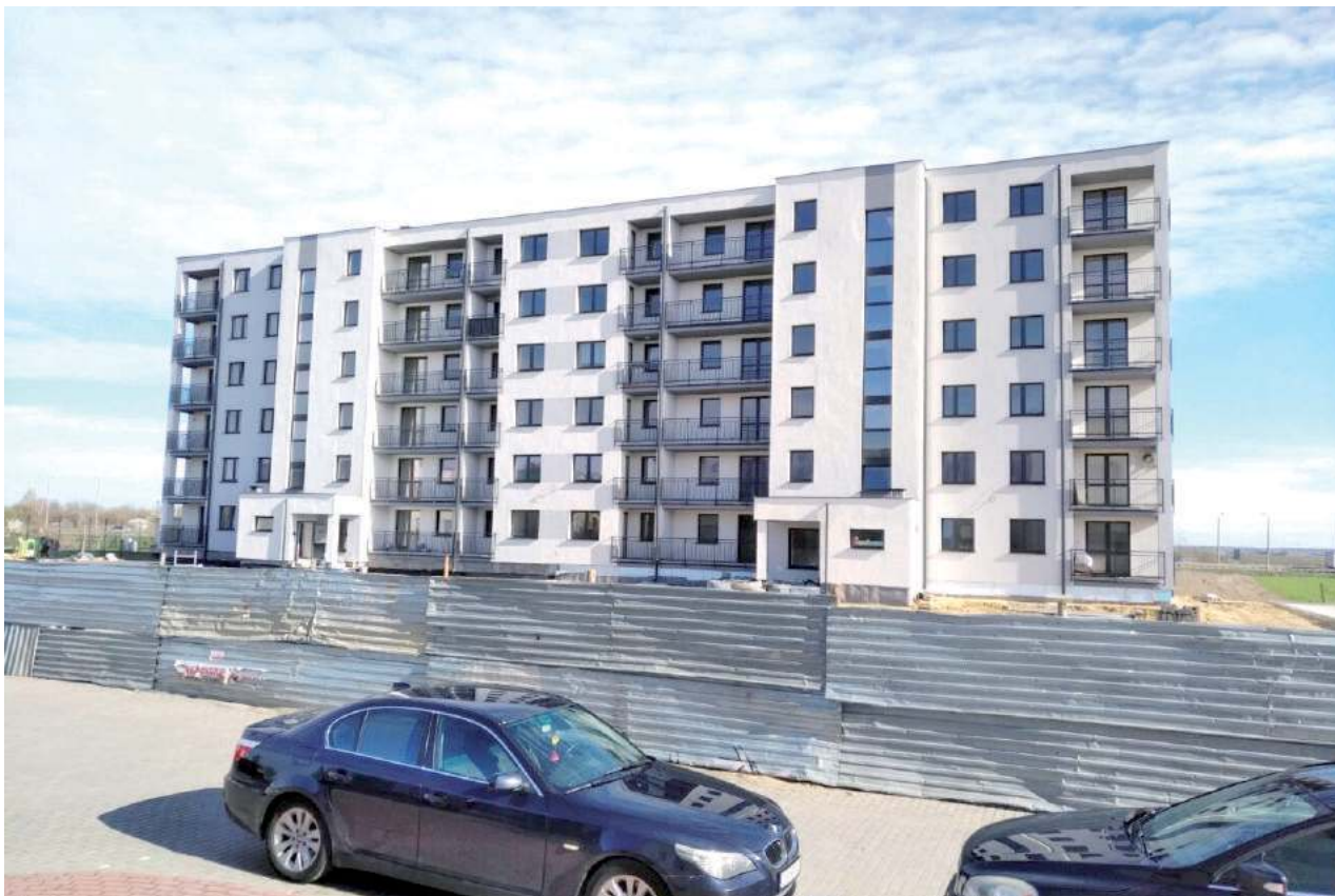
W sporze chodzi o pięciopiętrowy blok u zbiegu ulic Stanisława Tessaro i Aleksandra Wereszki przy obwodnicy, niedaleko nowego kościoła pw. bł. Stefana Wyszyńskiego. Na zdjęciach: stan robót z 4 kwietnia br.
