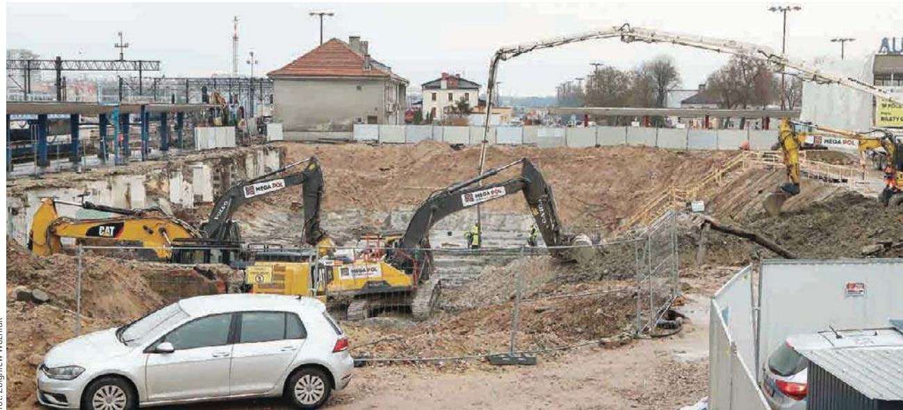
Budowa nowego dworca, jak też modernizacja stacji Olsztyn Główny toczą się bez przeszkód
