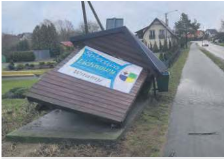
Przy wjeździe do Lichnów leżała wiata autobusowa.
