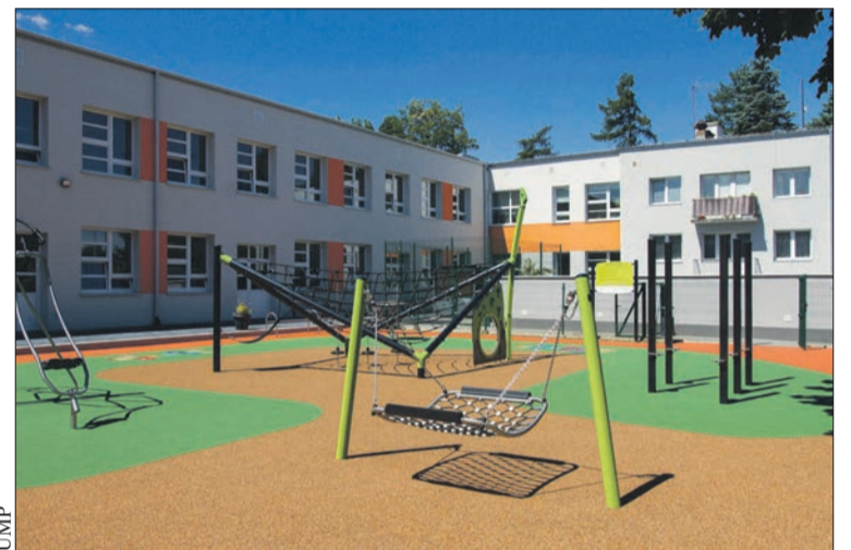
Ukończono termomodernizację w Szkole Podstawowej nr 5 na osiedlu Radziwie
