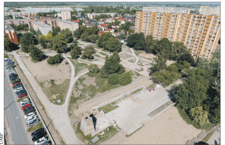
Trwają prace na dawnym cmentarzu żydowskim
