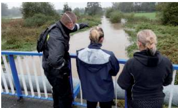
W środę poziom wody na rzece Oławie cały czas się podnosił. Tak sytuacja wyglądała na moście na ul. Brzegowej
