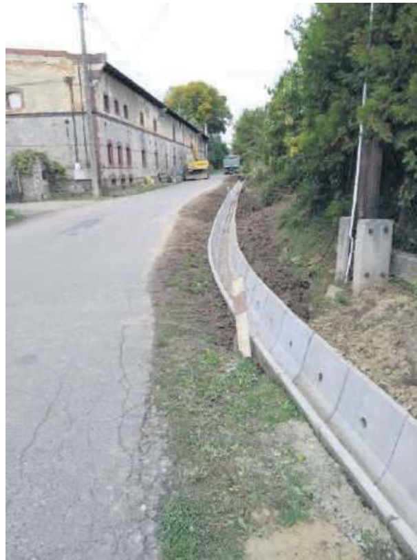
Rów przy drodze gminnej w Lipowej jest obecnie remontowany
