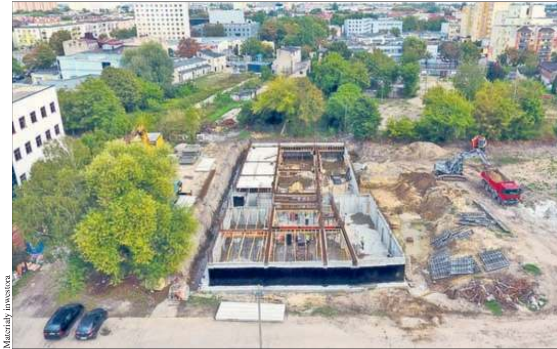
Trwa budowa hali garażowej w pierwszym budynku wielorodzinnym na osiedlu Nowy Manhattan
