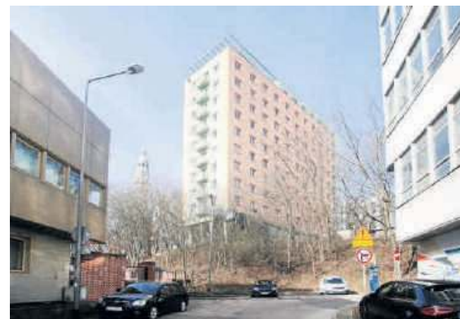
Nowa zabudowa dla Podzamcza będzie posadowiona w dużej części na zachowanych fundamentach przedwojennych
