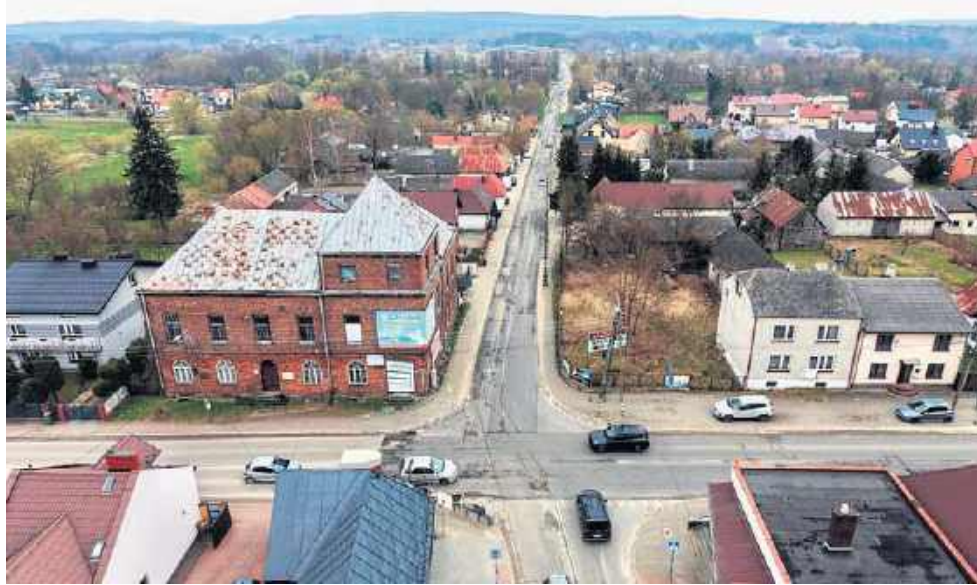
Ogłoszono przetarg na rozbudowę i przebudowę drogi powiatowej Daleszycy - Niwy
