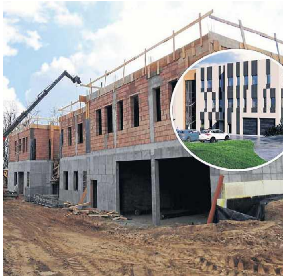
Prace przy budowie przychodni w Połańcu. Widać już drugą kondygnację.
