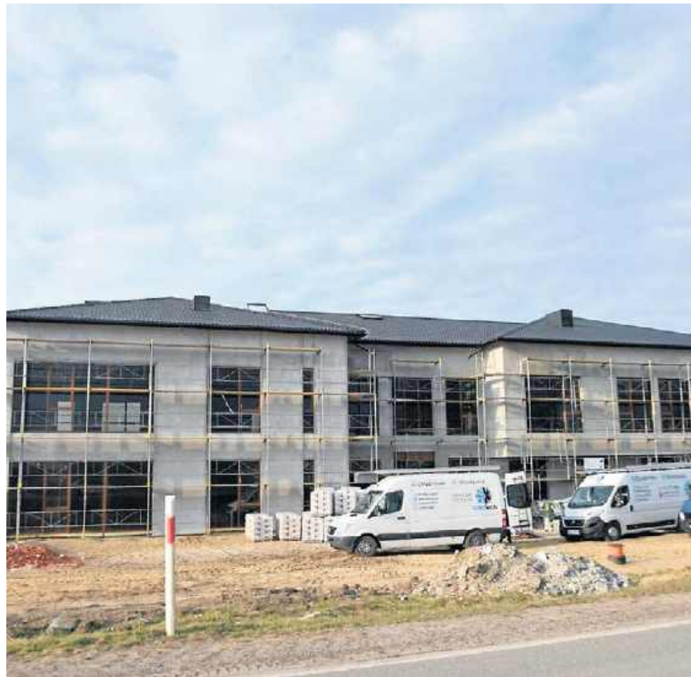
W Klwowie powstaje Centrum Usług Leczniczych, Rehabilitacyjnych i Kulturalnych.
