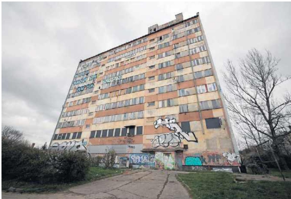
Kielce wyburzą budynek przy ulicy Młodej 4. Powstanie tu ponad sto mieszkań
