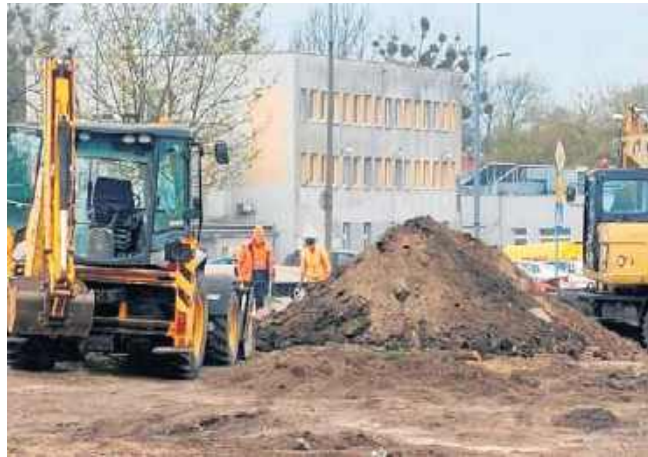
Ciężki sprzęt pracuje przy budowie nowego parkingu przed Radomskim Szpitalem Specjalistycznym.
