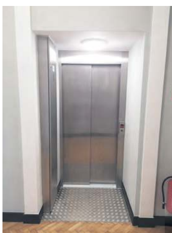
Wejście do windy na piętrze urzędu.
