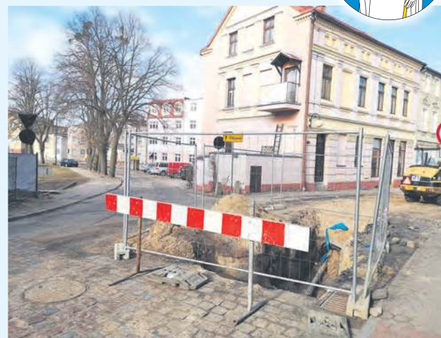
Z ruchu wyłączona została część ul. Chojnickiej. Objazd wyznaczono przez ul. Gabrychów.
