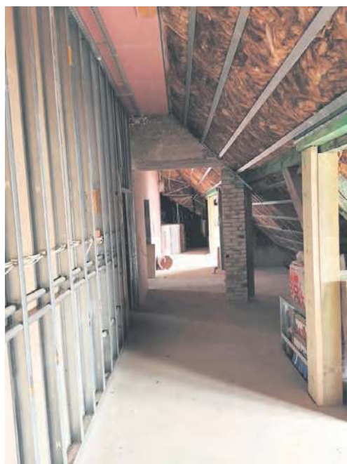
Korytarz ze ściankami działowymi.
