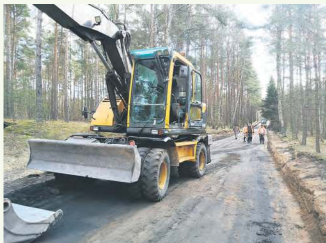
Do Łosin będzie prowadziła nowa, asfaltowa droga.
