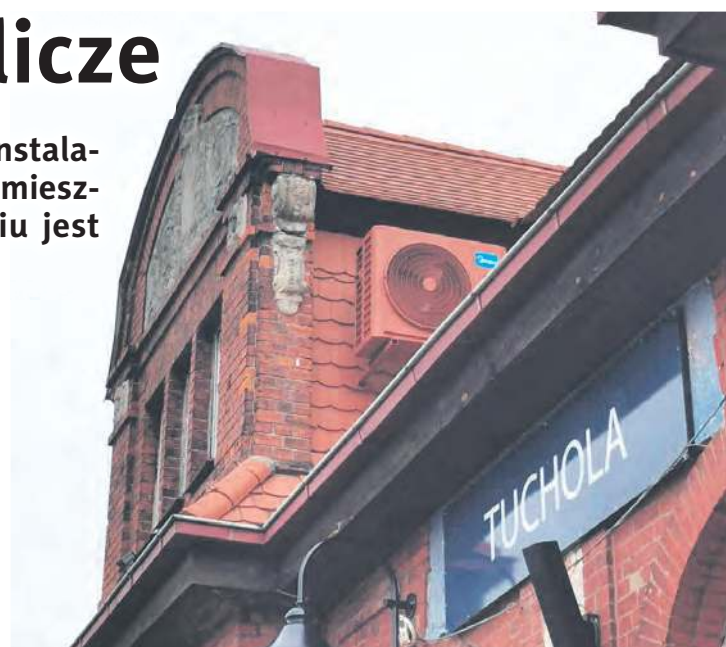
Na miejscu są już klimatyzatory.
