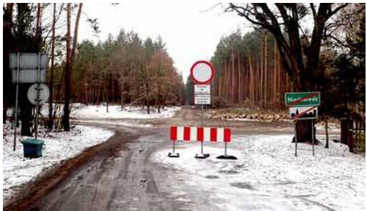
Rozpoczęła się wycinka drzew kolidujących z budową drogi wspomagającej Niedźwiedź-Zdunowo
