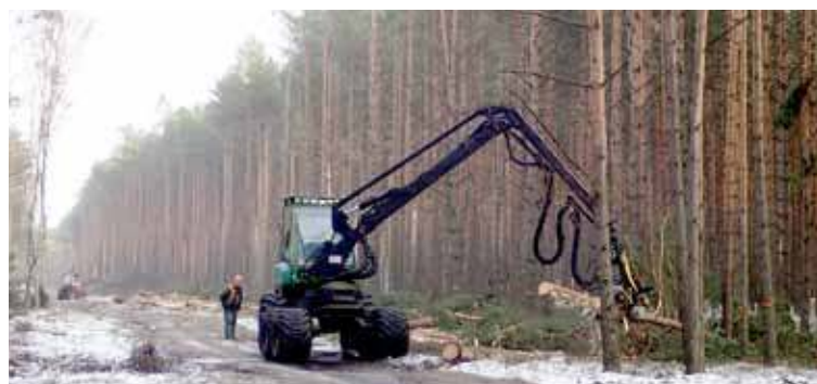
W marcu, po zakończeniu wycinek rozpoczną się roboty przy budowie opisywanej drogi
