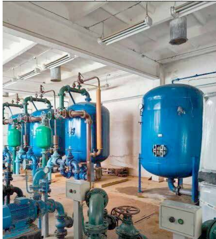
Widok na filtry i hydrofor w bud. SUW Dobra.
