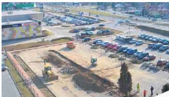
Inwestycja ma się zakończyć w czerwcu tego roku. Wykonawcą prac jest Rejon Budowy Dróg i Mostów w Krośnie
