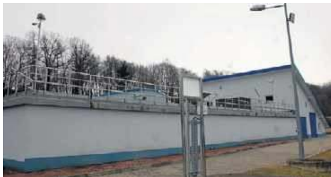
Zmodernizowana oczyszczalnia ścieków w Nowym Żmigrodzie
