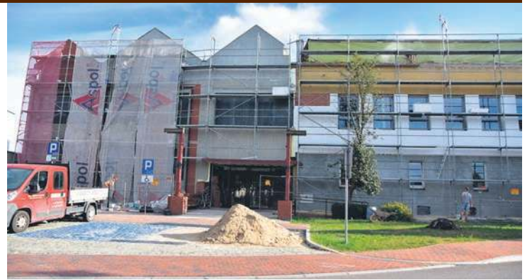
Aktualnie ocieplana jest frontowa ściana TOK-u.
