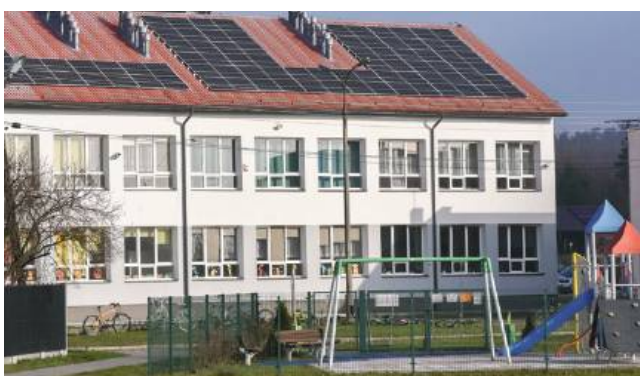
Szkoła w Terespolu-Kukielekach po termomodernizacji wraz z instalacją fotowoltaiczną.
