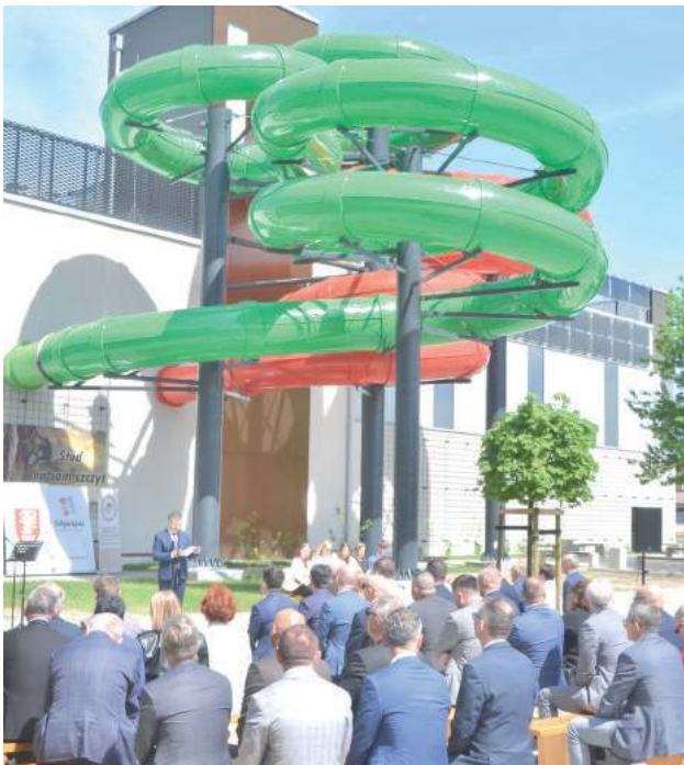
Wielkie kolorowe zjeżdżalnie, które widać z daleka, póki co cieszą tylko oko. Zjazd prowadzi do...recepacji i jest zamurowany. Zjeżdżalnia ma zostać uruchomiona dopiero po wykonaniu 2 etapu i przeniesieniu recepcji na front budynku
