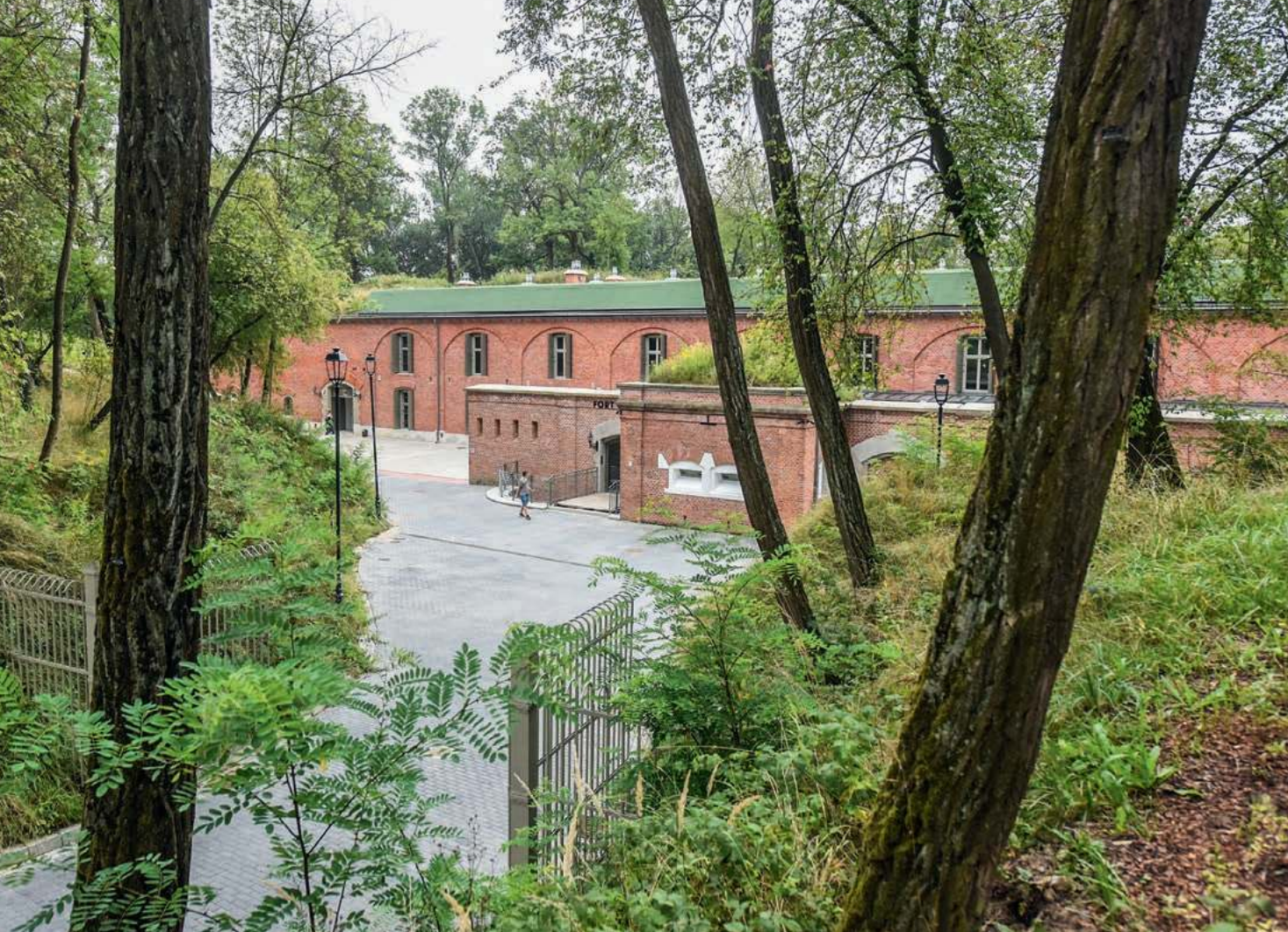
Fort 52 „Borek” – po generalnym remoncie w lipcu br. otworzono w nim filię Centrum Kultury Podgórze. Kraków, 21 sierpnia 2022 r.
