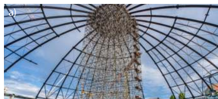
Fot. 3. Rusztowania podporowe: a) scalanie kopuły stalowej, b) tymczasowe podparcie zbiornika
