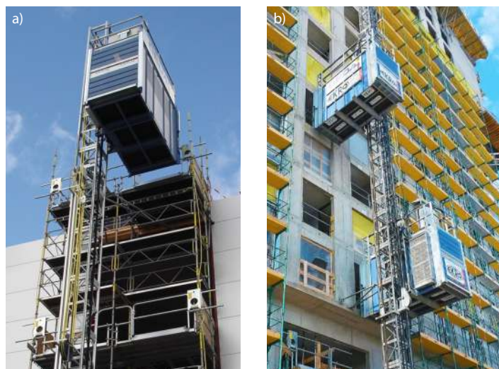
Fot. 3. Seria dźwigów GEDA PH: a) z pojedynczą kabiną (tzw. Single), b) z dwoma kabinami na jednym maszcie (tzw. Twin)
