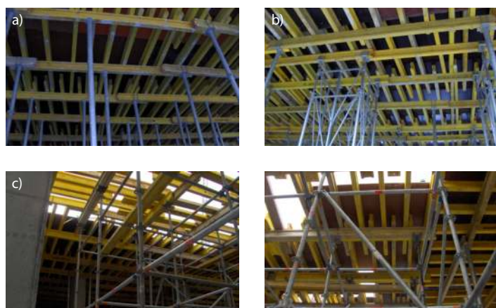
Fot. 1. Najczęstsze sposoby podpierania konstrukcji podczas realizacji budownictwa kubaturowego: a) regulowane teleskopowe podpory, b) wieże nośne, c) rusztowania podporowe
