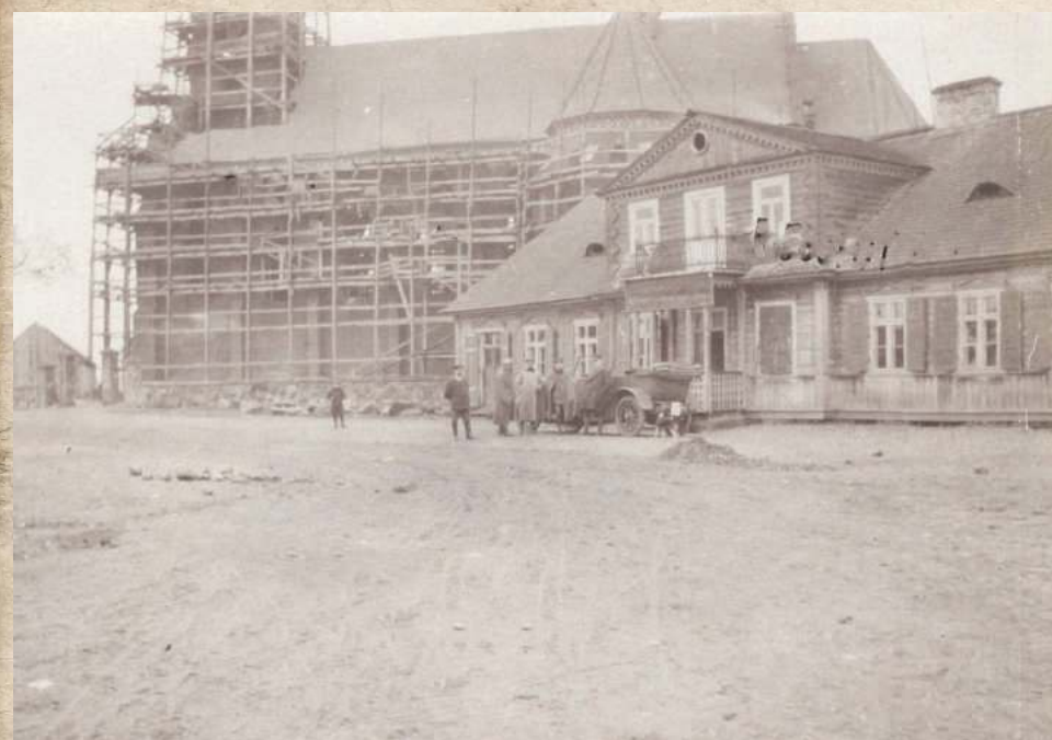
Budowa kościoła pw. Wniebowzięcia NMP w Stoczku Łukowskim, najpewniej około 1923 roku. Parafia w Stoczku (niegdyś Sebastianowie) ma początki w XV wieku. Pierwszy drewniany kościół spłonął w 1746 roku, kolejny w 1776 (jeszcze nie był wykończony), kolejny poświęcono w 1809. Po wybudowaniu obecnego został sprzedany do nowo powstałej parafii w Jedlance, gdzie spłonął w 1973 (bądź w 1975). Zdjęcie znalezione na portalu fotopolska.eu, znalezione na aukcji internetowej
