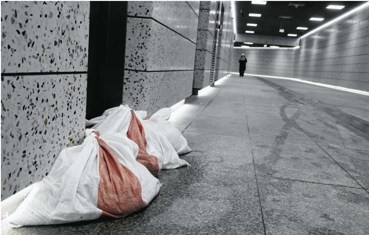
• Worki z piaskiem na stacji metra Kondratowicza mają zatamować napływ wody
