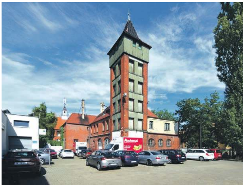
Charakterystyczna wieża obserwacyjno-ćwiczebna remizy w Łagiewnikach
