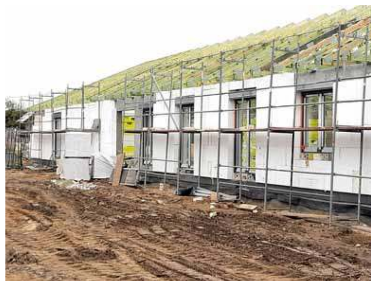
W budynku przedszkola widać już konstrukcję dachu i okna
