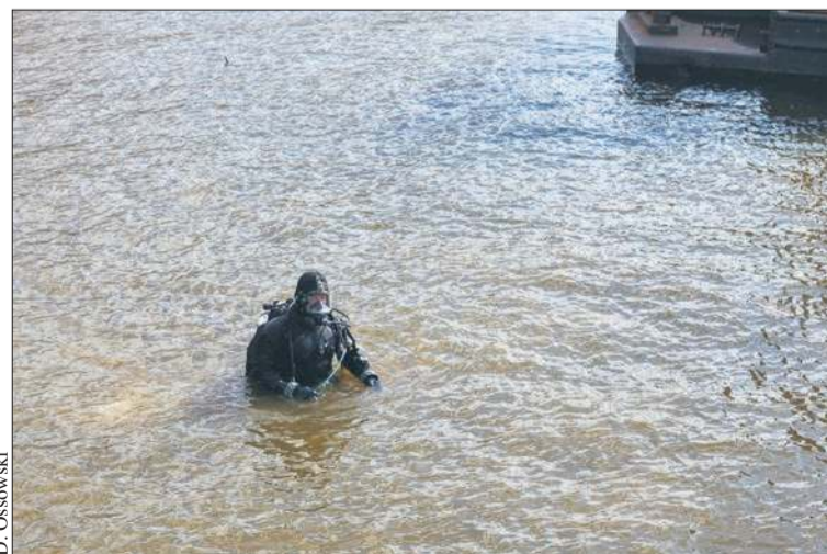
Nurkowie oczyszczali teren przy rampie
