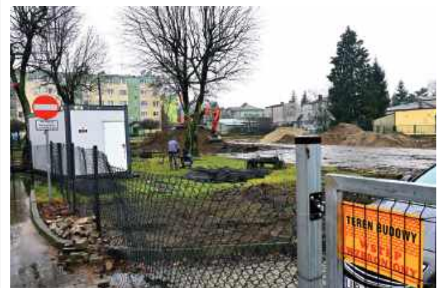
Całkowita wartość umowy na budowę wynosi 5 650 000 zł brutto. Wyłoniono wykonawcę - firmę z Turowoli w powiecie łęczyńskim
